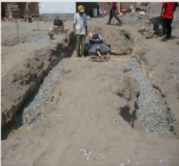
Tipo de zanjas de infiltración horizontal
