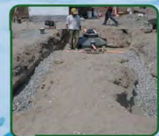
Zanja de infiltración
