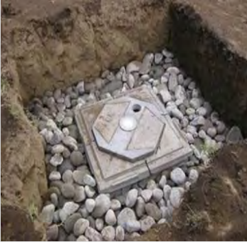
Tipo de pozo de absorción vertical
